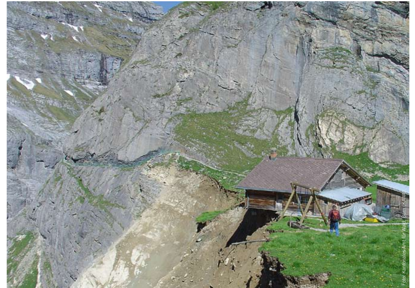
▲ Die Stiereggütte oberhalb Grindelwalds musste wegen Gletscherrückzug und einstürzender Moräne 2006 abgebrochen werden.
